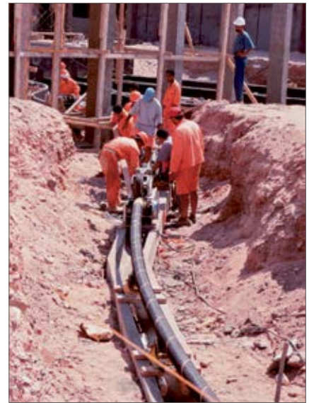
Egypt-Jordan Cable Laying
